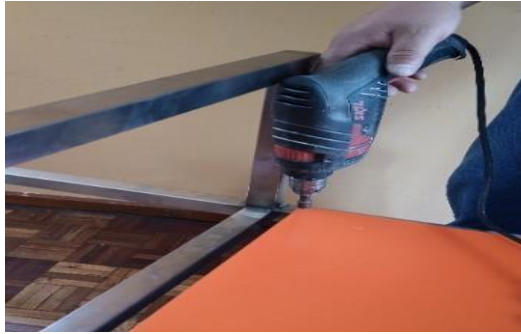
Figura 19. Instalación de pernos auto perforantes
