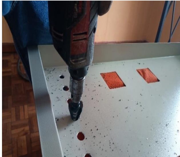
Figura 17. Apertura de perforaciones a 25 milímetros con ayuda del taladro de mano y broca tipo cono
