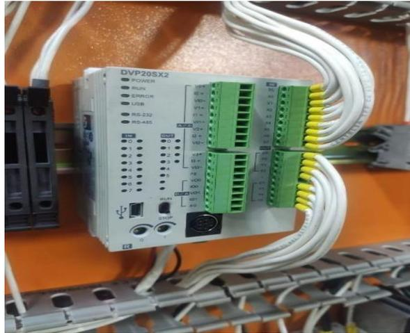
**Figura 4.** Programador lógico programable visto de cerca
